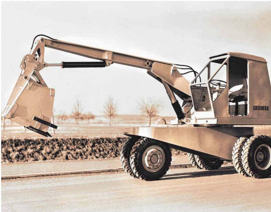
Mit dem L 300 konstruierte Hans Liebherr den ersten Hydraulikbagger Europas. Jetzt ist der 75 000. Bagger bei der Liebherr-Hydraulikbagger GmbH gebaut worden. FOTO: LIEBHERR
