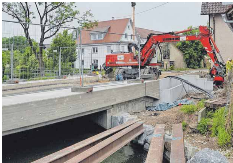
Noch etwas müssen sich die Sinner gedulden, doch demnächst soll die Gießenbrücke fertig werden.
