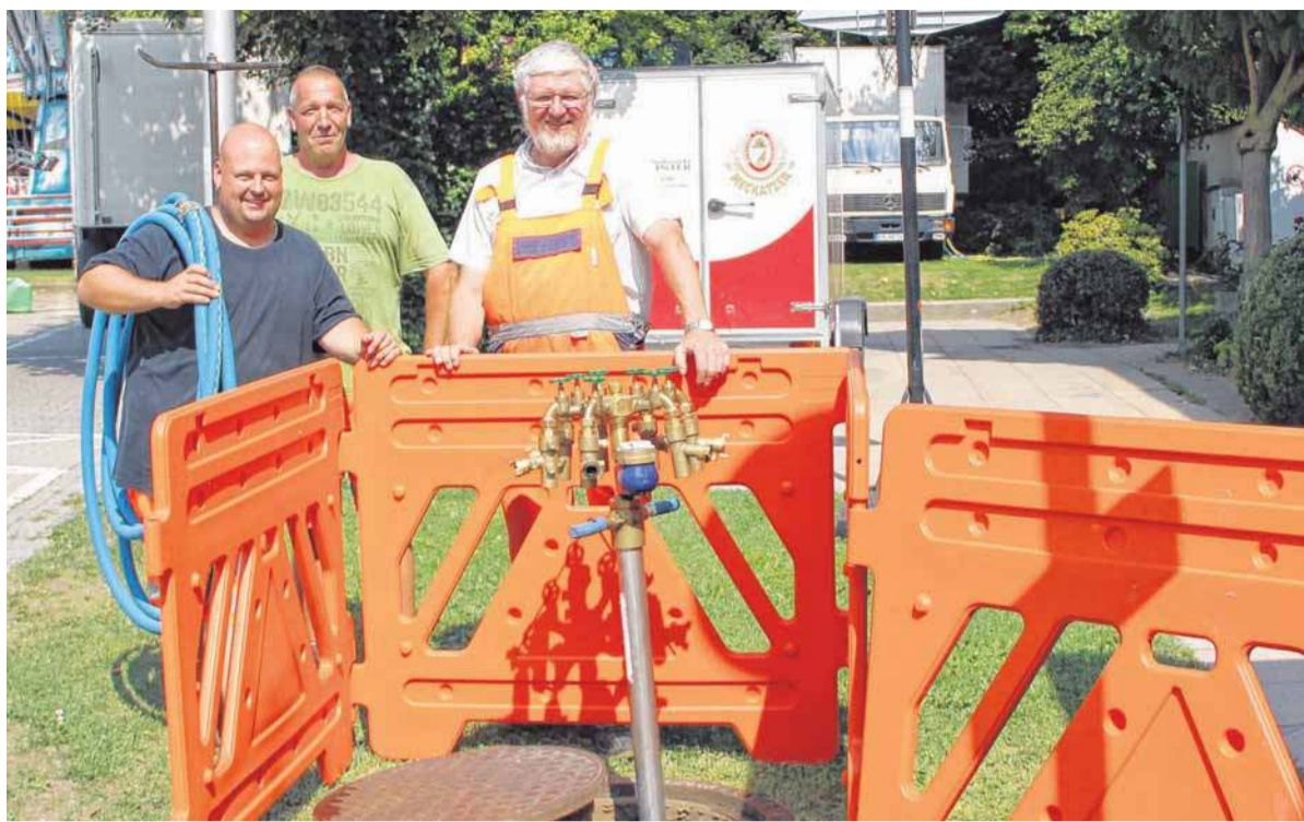
Daniel Kühny, Frank Baumgartl und Thomas Funk (von links) vom Aulendorfer Betriebshof platzieren die Festplatzverteiler zur Wasserversorgung.
