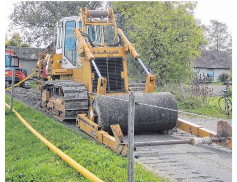
Beim grabenlosen Verlegen nimmt ein Pflug das elastische Gasrohr im Winkel von 360 Grad auf und pflügt es beim Abfahren der Trasse direkt hinter sich in den Boden ein.
