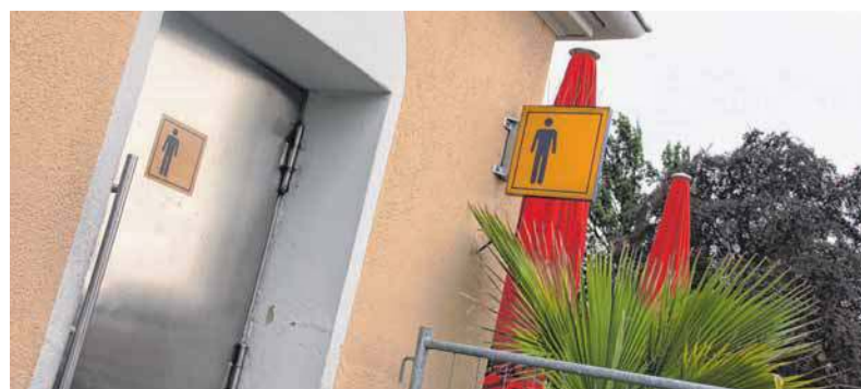
Im kommenden Jahr soll es am Aulendorfer Bahnhof eine öffentliche Toilette geben. FOTO: GUNNAR FLOTOW
