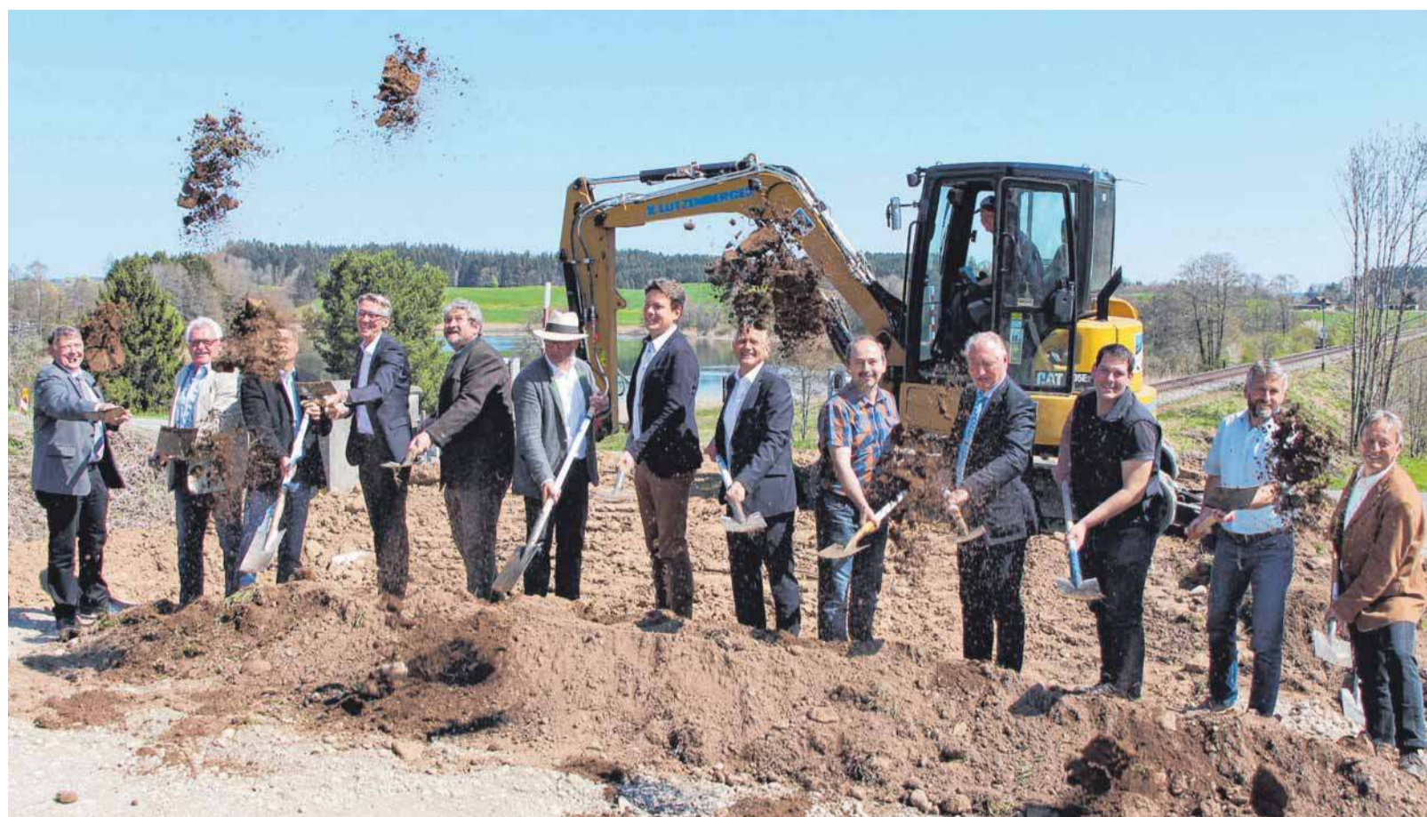
Schwungvoller Baubeginn: die Vertreter von Kommunen, Kreis, Bahn und Baufirmen beim Spatenstich.
