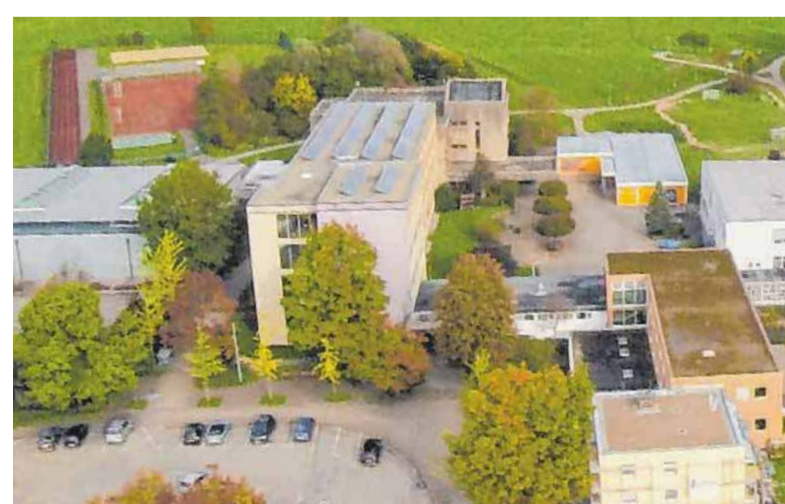
Für die Sanierung der Realschule mit Hauptbau, 80er-Jahre Erweiterungsbau, Sonderbau sowie Foyer und Umkleidestrasse hinter der Sporthalle bekommt die Stadt Wangen Fördermillionen vom Bund.
