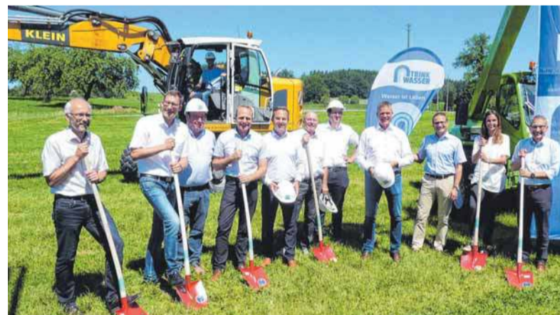
Mit dem Spatenstich beginnt für den Zweckverband Haslach-Wasserversorgung ein neuer Abschnitt im Trinkwasserverbundsystem. FOTO: VS
