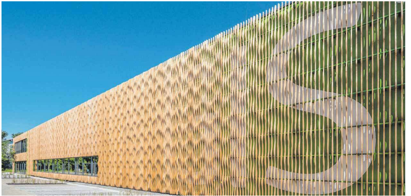
Preiswürdig: Die Elobau-Logistikhalle mit Büros, errichtet in reiner Holzbauweise im Energie-Plus-Standard.
