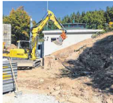
Vor dem Technikgebäude entsteht ein Anbau samt Aufzug.
