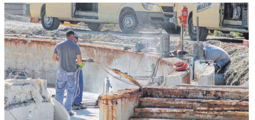
Arbeiter passen die Beckenköpfe für die neue Oberkonstruktion aus Edelstahl an.
