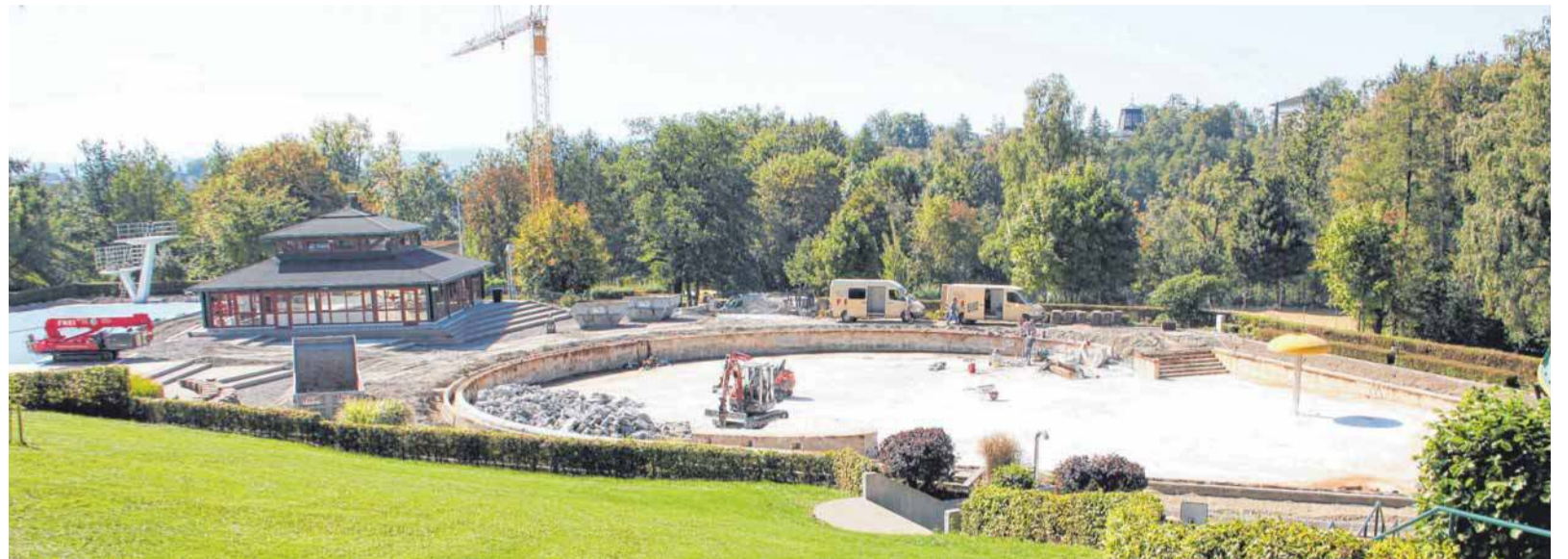
Im Mittelpunkt der Arbeiten zur Generalsanierung des Freibads steht derzeit das Nichtschwimmerbecken (rechts).
