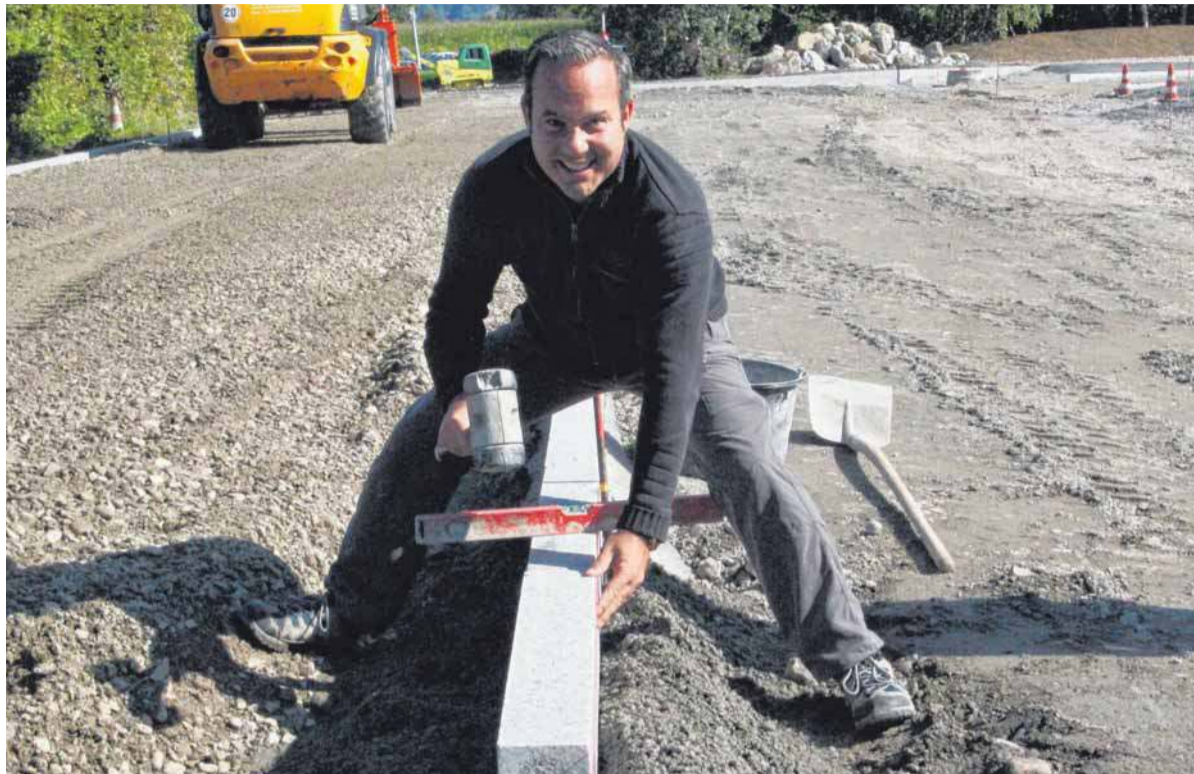
Raimund Haser schwingt den Gummihammer beim Parkplatzbau.
