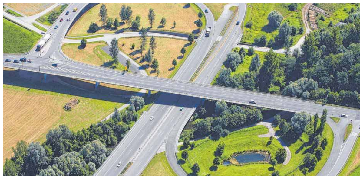
Das Ende der ausgebauten B 30 im Ravensburger Süden: Bis Ende 2019 soll man von hier aus bis hinter Untereschach vierspurig weiterfahren können. Der erste Teilschnitt der neuen Straße wird am Donnerstag eröffnet. ARCHIVFOTO: ROLAND RASEMANN
