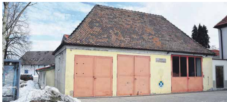
Noch gibt es keine Pläne für eine Weiternutzung des alten Feuerwehrhauses in Wohmbrechts. Bürgermeister Uwe Giebl rechnet aber mit Anfragen. FOTO: SUSI DONNER
