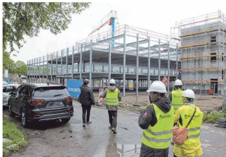
Investor Wolfgang Forster (vorne) führt Interessierte durch das gerade entstehende Parkhaus, das ab Herbst rund 370 Stellplätze auf drei Etagen bieten wird. FOTO: SUSI WEBER
