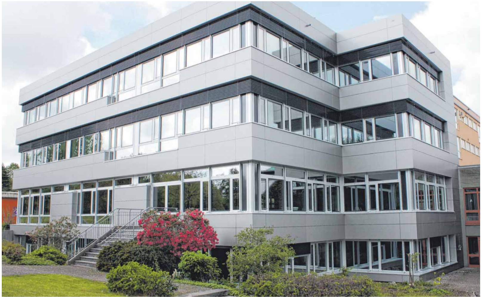
Optisch und ökologische ein Zugewinn: die neue Blechfassade des 80er-Jahre-Erweiterungsbaus der Wangener Realschule.
