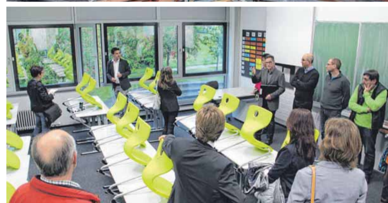
Ein Klassenzimmer während der Modernisierung und dem Einbau von neuen Fenstern (oben) und danach bei der Besichtigung. FOTOS: SCHULE/BEE
