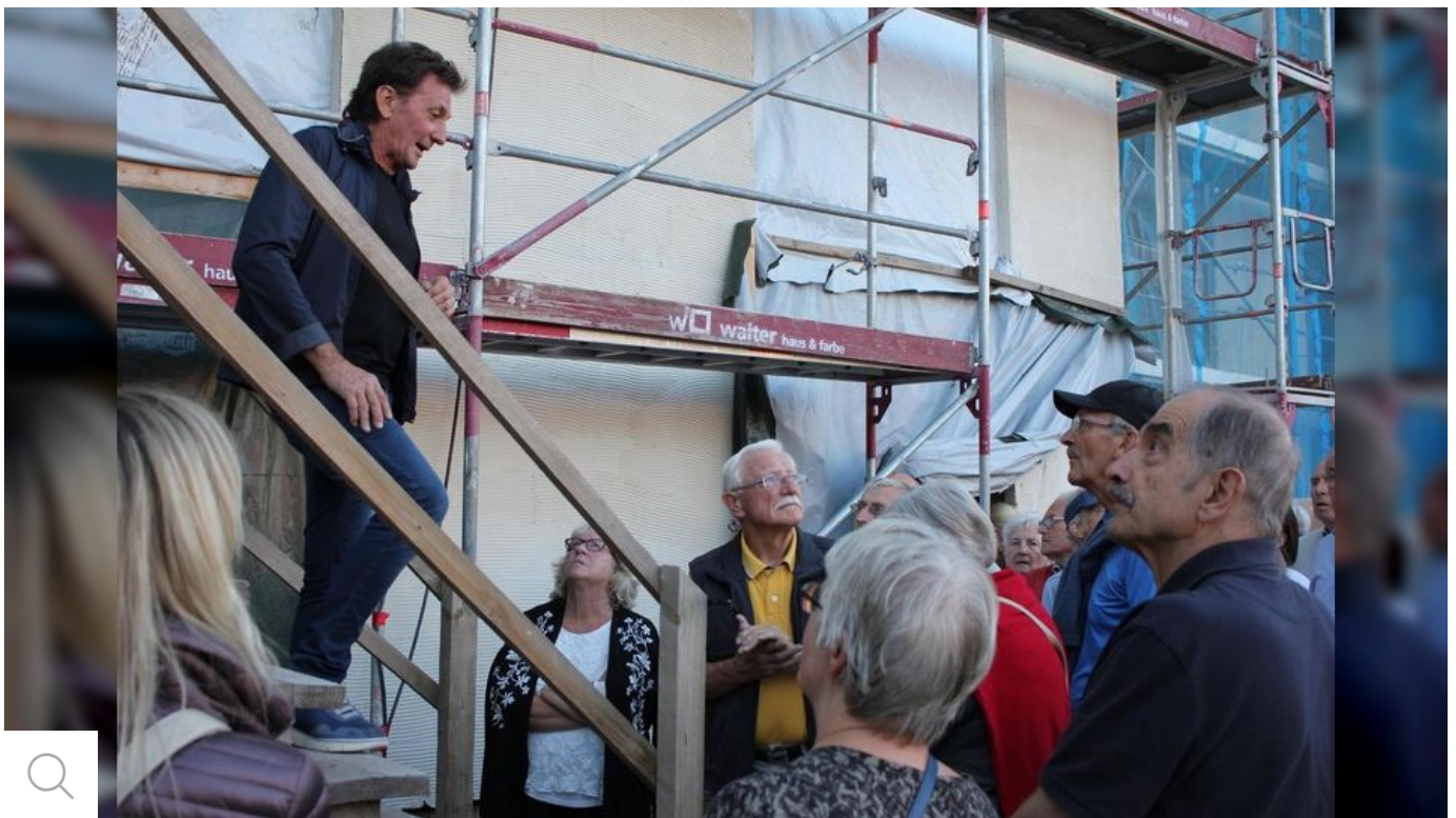
Investor Hermann Müller (auf der Treppe) führt Interessierte im Sommer 2019 durch die Baustelle des Hotels „Kaiserhof“, dessen Eröffnung sich krisenbedingt verschiebt. (Foto: Archiv: Lena Müssigmann)
